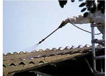
Inoltre, in caso di trattamenti di coperture in cemento-amianto si impone, per il fissaggio delle fibre, un'operazione preliminare di pulizia che può determinare un notevole rilascio delle stesse.
