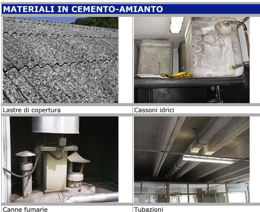
Sono da considerare friabili i soffitti spruzzati a scopo antincendio, anticondensa o fonoassorbente (*cemento acustico*), e il materiale spruzzato su travi, tubazioni e caldaie.
