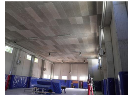
Comune di Castelfrentano (CH). Efficientamento energetico palestra
