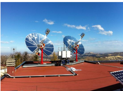
Comune di Montedodorisio (CH) Installazione dispositivi per trigenerazione
