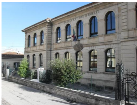
Comune di Tocco da Casauria (PE). Sostituzione infissi scuola elementare
