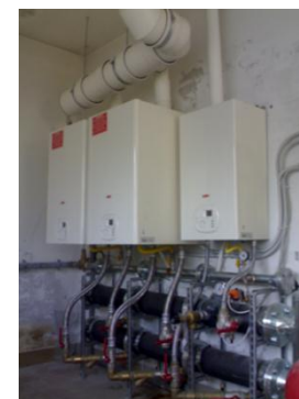
Comune di Tortoreto (TE). Sostituzione caldaie scuola materna
