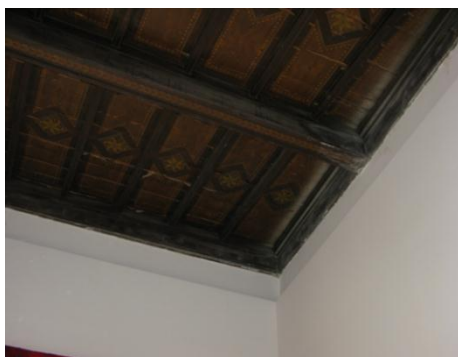
Comune di Pettorano sul Gizio (AQ). Lavori di efficientamento energetico Sala Consiliare
